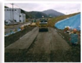
締固めにより密度が容易に得られるポンテラン改良土
